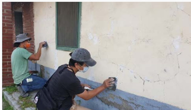
牆面縫隙補土
